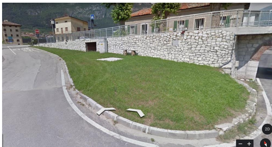
L'area attrezzata in fase di apprestamento da parte della PAT
