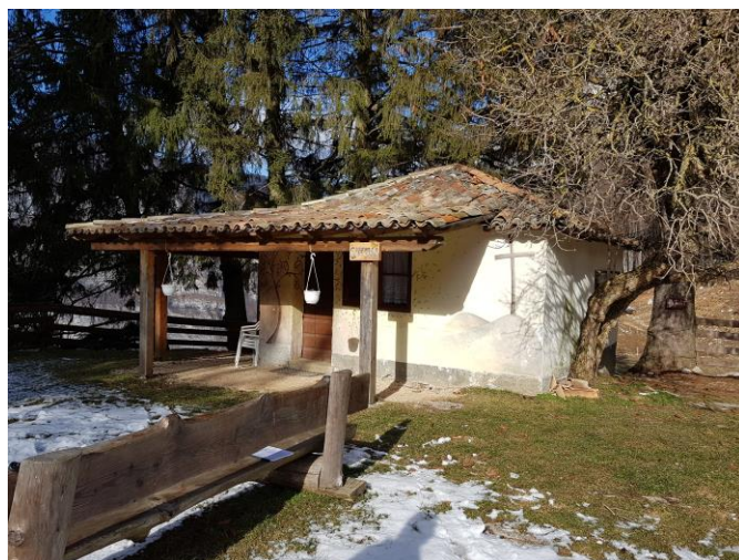
La piccola cappella posta a fianco dell'edificio principale
