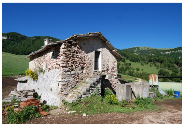
la ex chiesetta vista da monte
