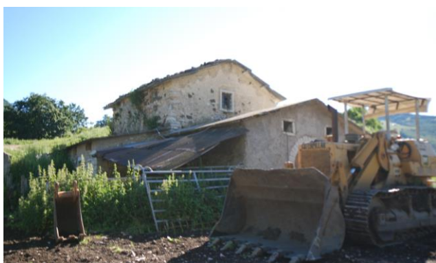
la ex chiesetta vista da sud ovest
