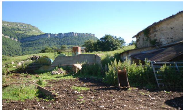
i rudreri dell'ex deposito (p.ed. 2005)
