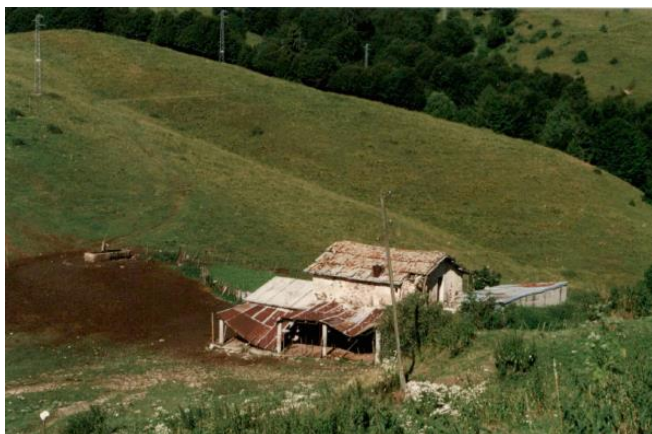
La ex chiesetta con le tettoie, ora demolite, visti da monte
