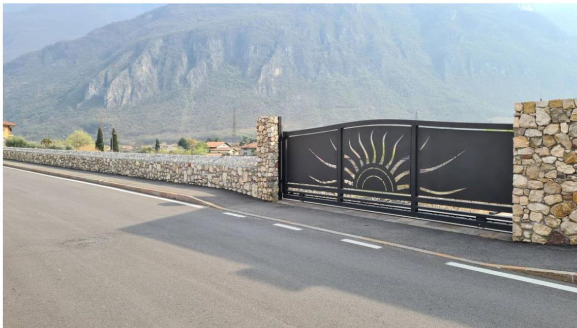
Figura 2.12: Accesso dell'edificio adiacente alla lottizzazione dopo i lavori in via Massa (foto 2022).
