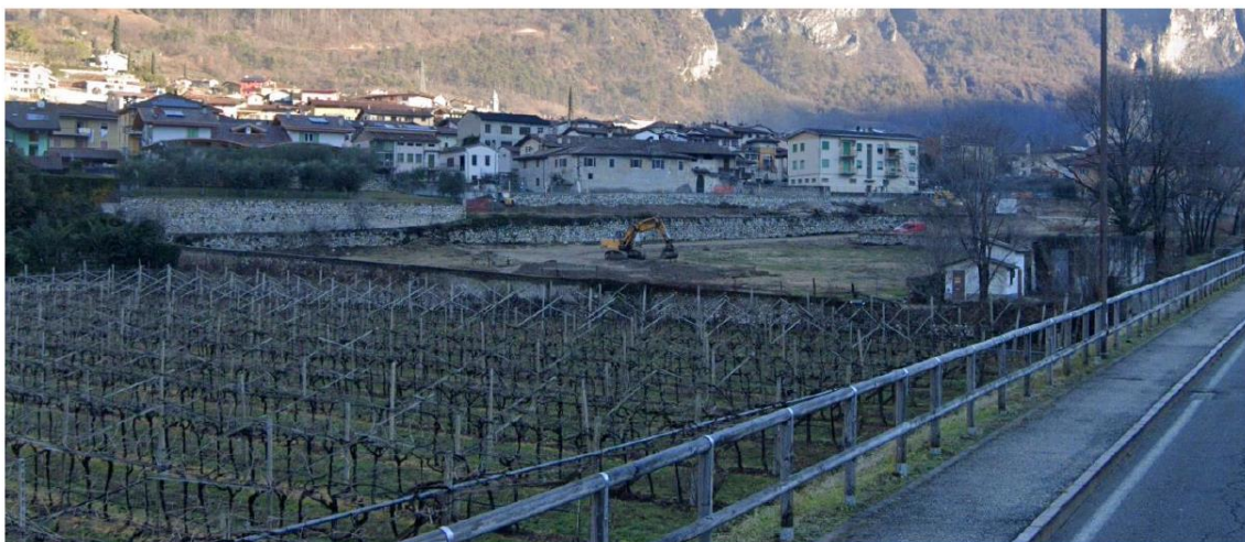
Figura 2.1: Vista dalla SP90 (sud ovest).
