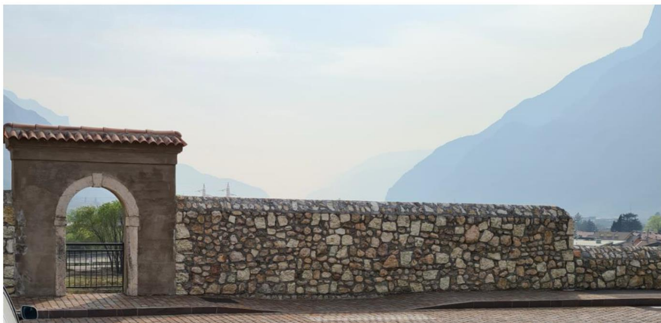
Figura 5.6: Vista del muro e del portale presso via Massa.
