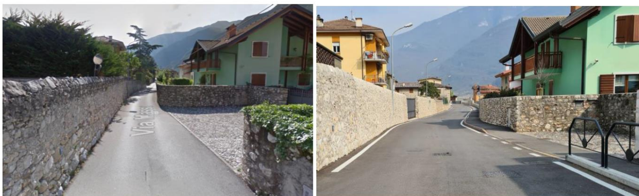
Figura 2.8: Via Massa prima (a sx) e dopo (a dx) i lavori di sistemazione nel tratto a ovest dell'area in esame.
