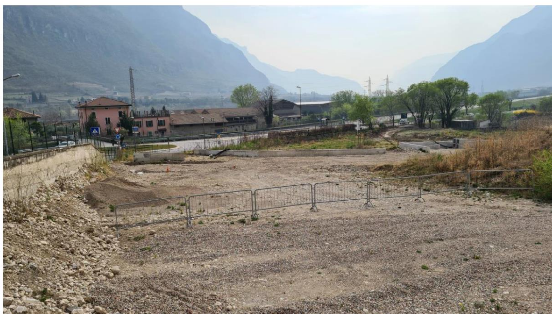
Figura 2.4: Vista in direzione della SP90.
