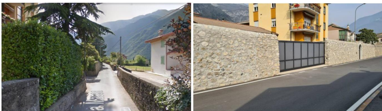
Figura 2.9: Via Massa prima (a sx) e dopo (a dx) i lavori di sistemazione subito a ovest dell'area in esame.
