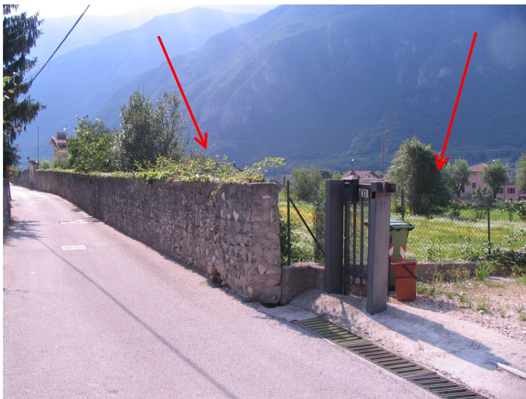
Vista nord-ovest strada da ampliare via Massa (13)
