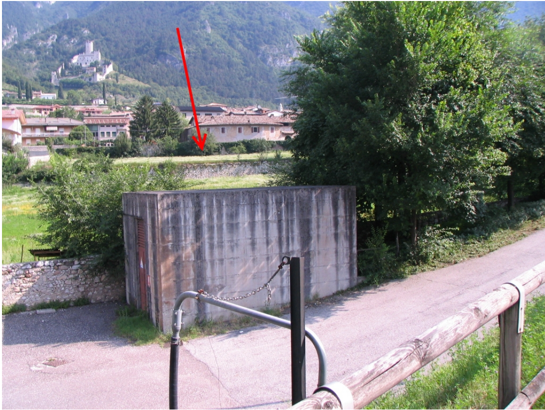
Vista sud cabina elettrica esistente p.ed. 1642 (19)
