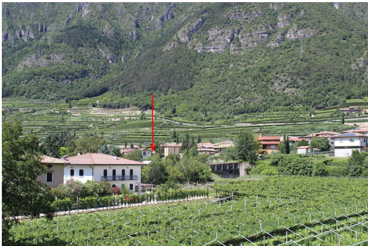
Vista dal ponte di Vò Destro (1)
