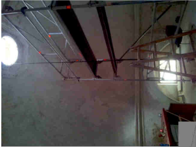
Il restauro della luce attuato con la riapertura del foro centrale e la «ricostruzione» della lanterna
